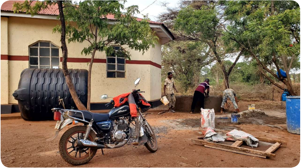
Das Beton-Fundament für den Tank entsteht - © Edith Tumaini Marandu
